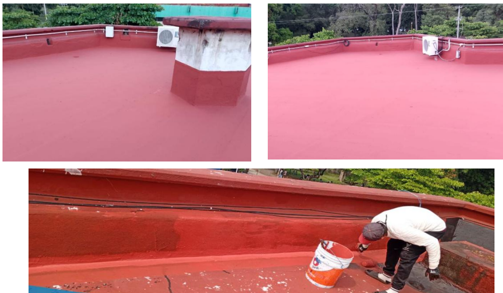
Ilustración 26: Impermeabilización
