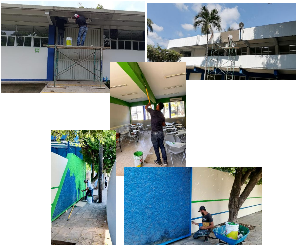
Ilustración 25: Rehabilitación, Mantenimiento y Pintura
