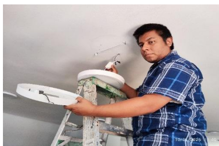
Ilustración 32: Sustitución de lámparas
