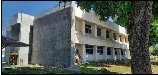
Edificio J (Laboratorio de cómputo)
